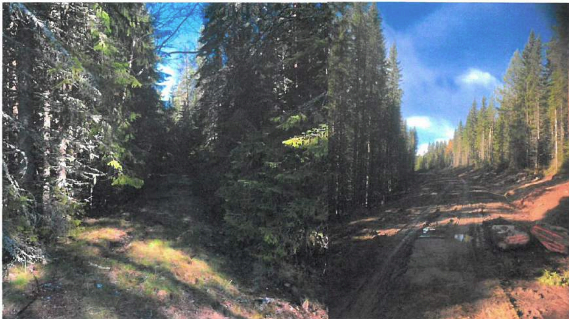
Opprusting av Gyltbergsveien, Sørskogbygda. Elverum kommune er eneeier. Veien ferdigstilles 2023..
